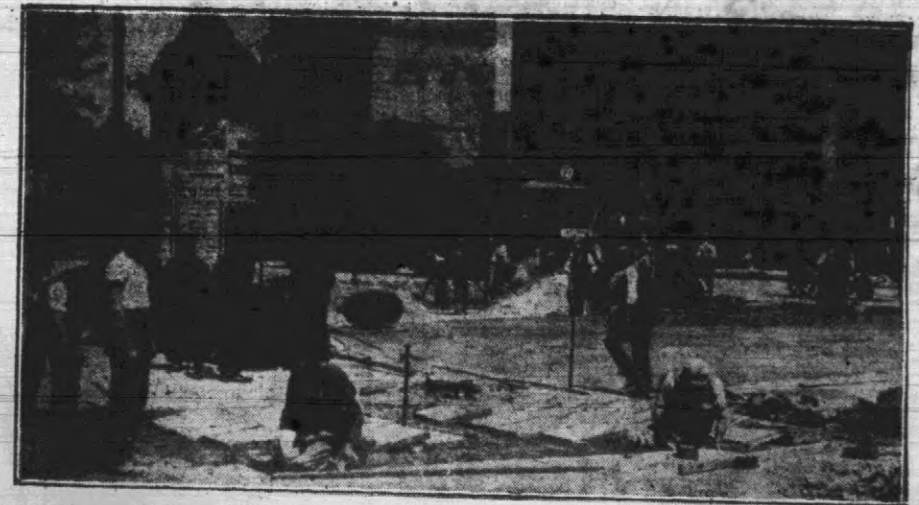
...niszczenie użytej jezdni...
