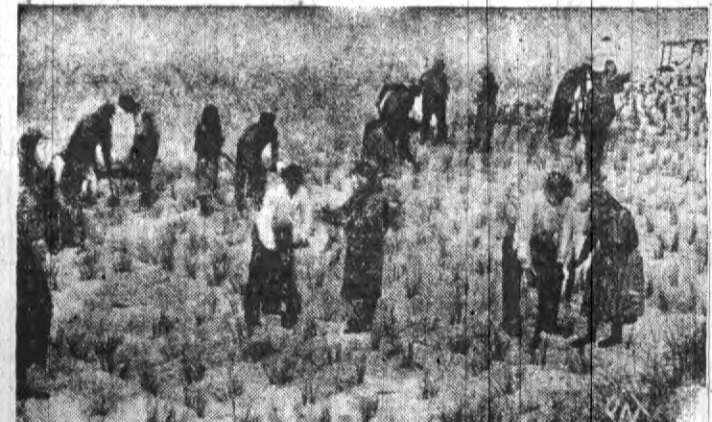
Na najbardziej zagrożonych odcinkach morza polskiego rozpoczął Urząd Morski prace nad zakładaniem plantacji traw, które przed rozwianiem utrzymują piaski wydm. Zdjęcie przedstawia prace rybaków kaszubskich na odcinku pod Kuźnicą na półwyspie Helskim.
