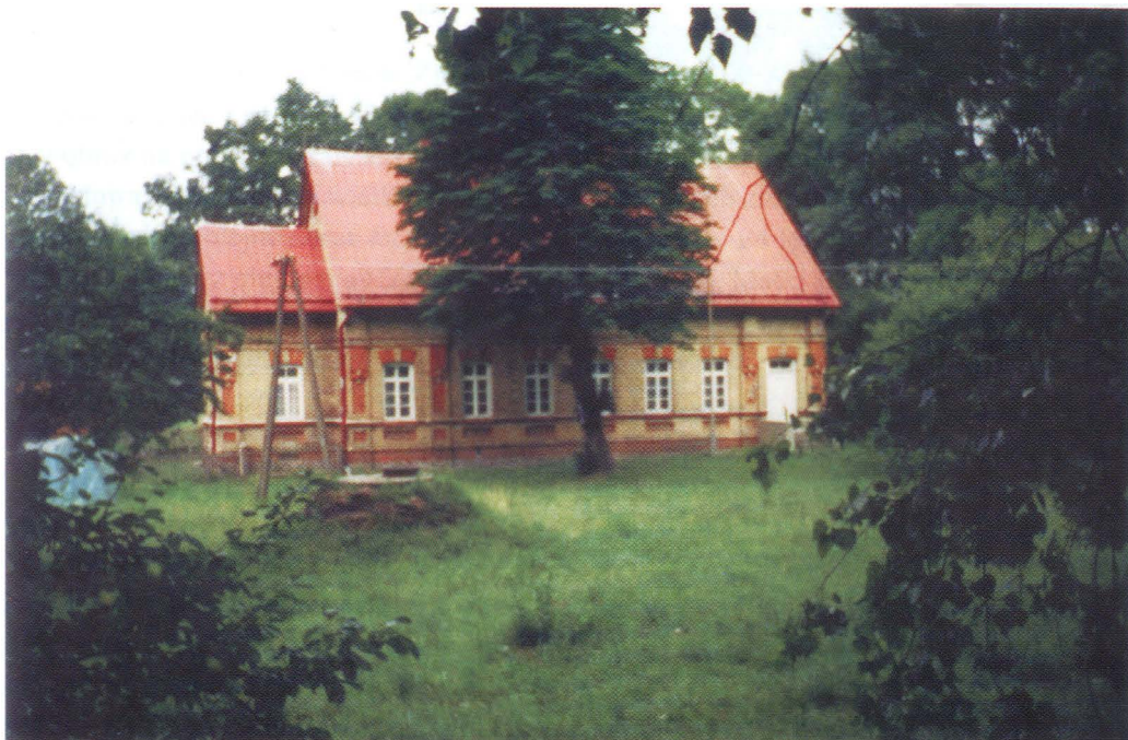
Dom Śluzowego w Dębowie (fot. G. Ryzewski)
