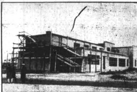
Swietlica pod dachem przeszło rok stoi niewykończona.
