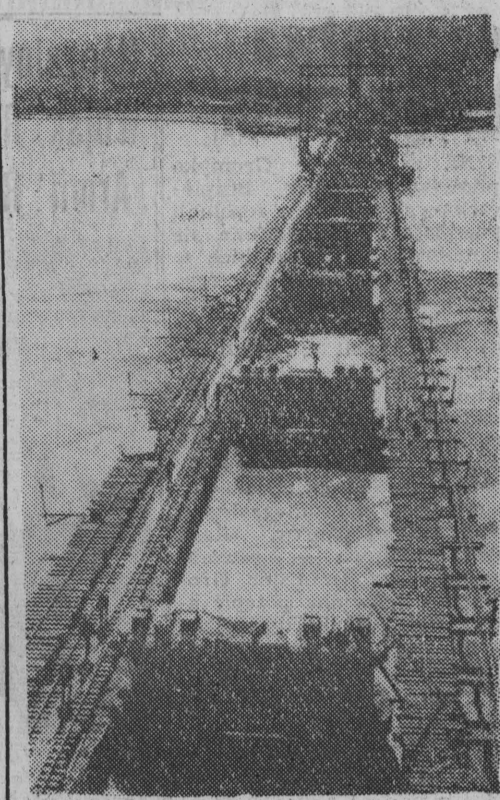
Na Żółtej Rzece w pobliżu Czengeczou (prowincja Honan) w Chinach zakończono już zasadniczy etap budowy nowego mostu kolejowego. Będzie to najdłuższy most tego rodzaju w Chinach. Jego długość wynosi blisko 3 km. Znajdzie się on na ważnym szlaku kolejowym Pekin — Kanton. Most został zaprojektowany przez chińskich konstruktorów. W budowie pomagają jednak także specjaliści radziecy. NA ZDJĘCIU: fragment nowego mostu. Fot. — CAF
