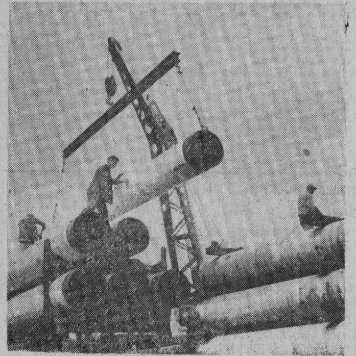
NA ZDJĘCIU: przewożenie rur ze składowiska na miejsce spawania.
