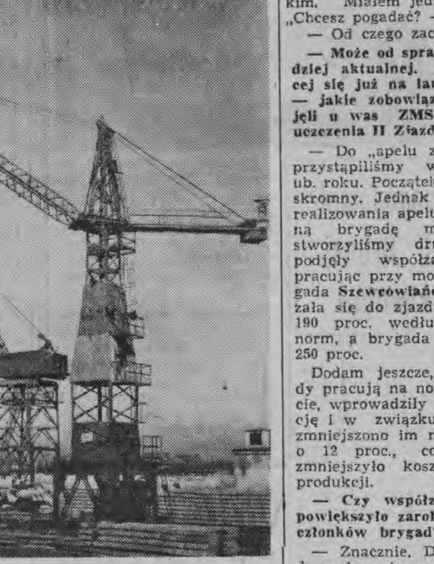
NA ZDJĘCIU: fragment placu w gotowym prefabrykowanym NA ZDJĘCIU: fragment placu w gotowym prefabrykowanym
