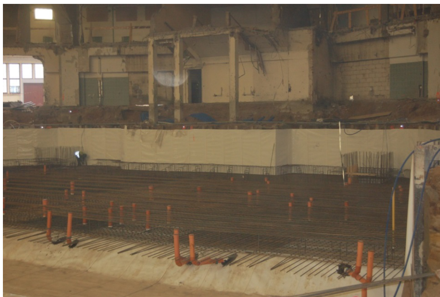
Rys. 6. Ułożona izolacja na ścianie zabezpieczającej, układane jest zbrojenie płyty fundamentowej
