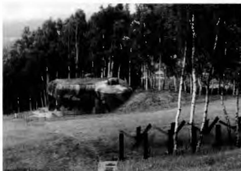
Czechy, okolice Nachodu. Tradytör N-S-82 „Březinka” z 1937-1938 r. Stan obecny po rekonstrukcji i umieszczeniu makiet kopuła. Fot. J.Chorzępa, 1997.
