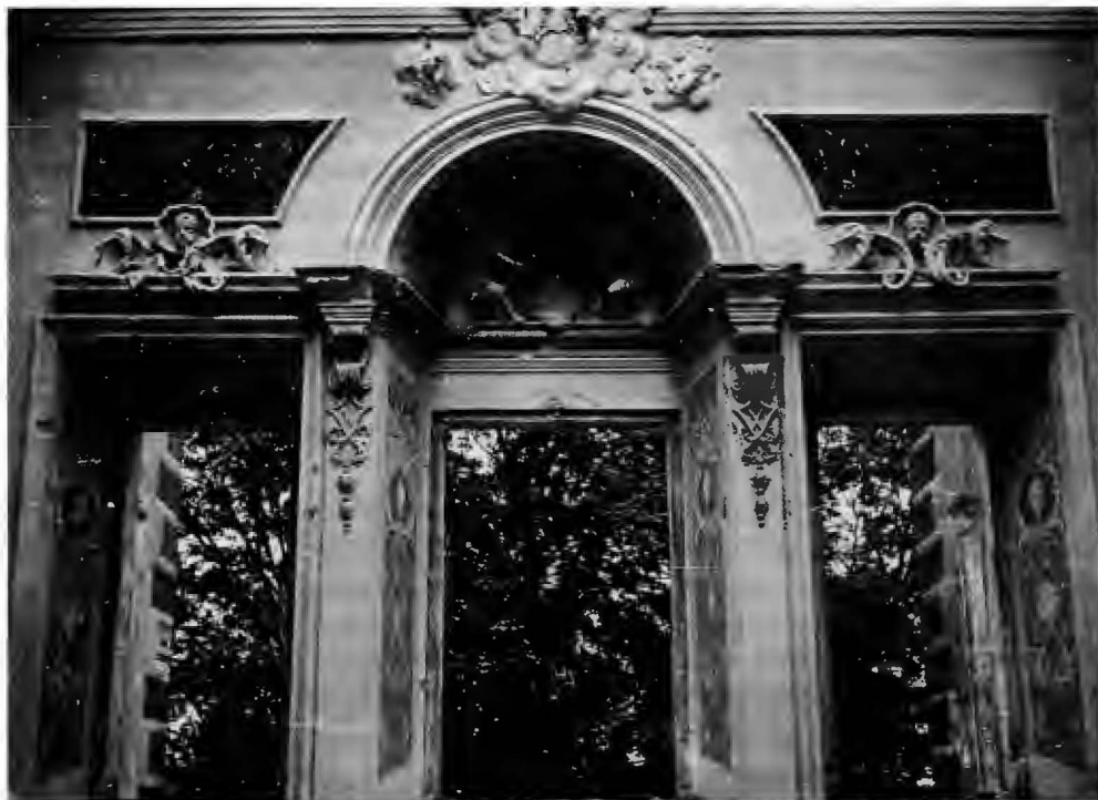
Okna kaplicy w Pałacu Opatów. Stan z 1946 r.
