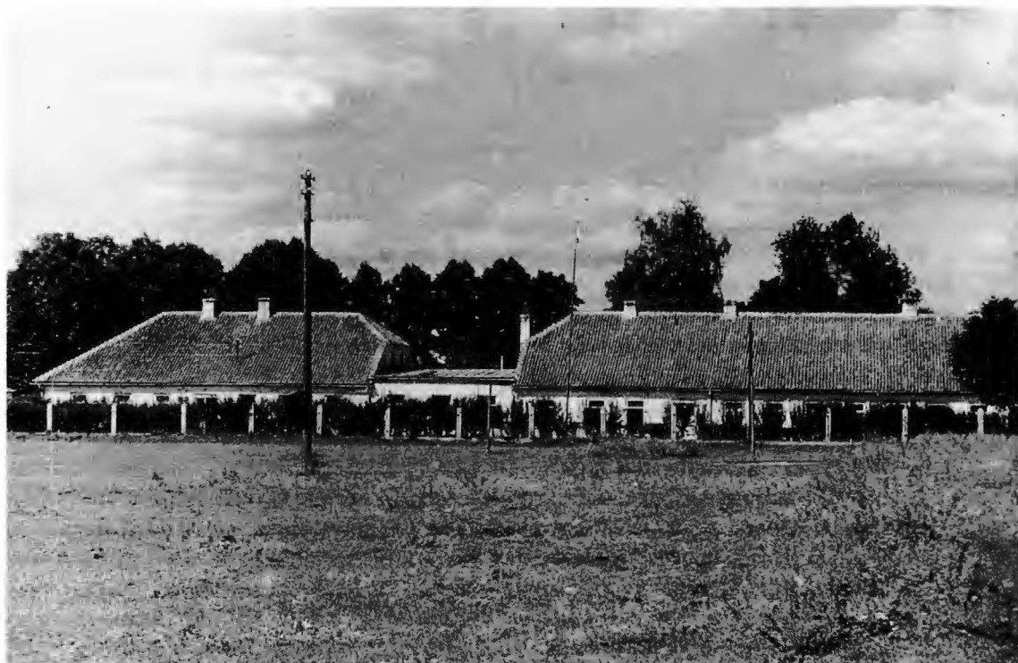
Supraśl, zespół mieszkalno-fabryczny Jansenów przed przebudową. Fot. W. Porzkowski, 1962 r.
