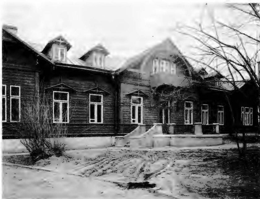
Elewacja frontowa budynku przy ulicy Świętojańskiej 17.
