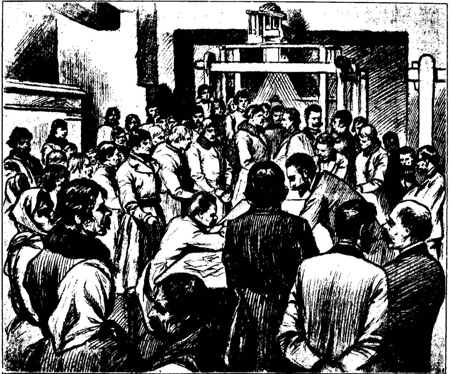
Otwarcie kasy pożyczkowo-wkładowej dla włościan w Siennicy Różanej. Zapisywanie się na członków.
