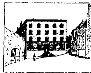
Więzienie „Eveché“ w Genewie.
