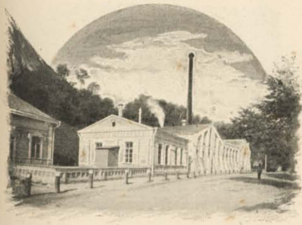
Stacja pomp i studni artezyjskie.
