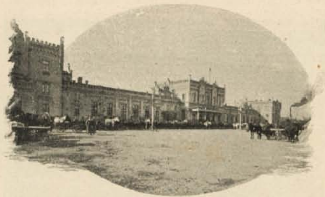
Dworzec kolei poł. zachodnich.
