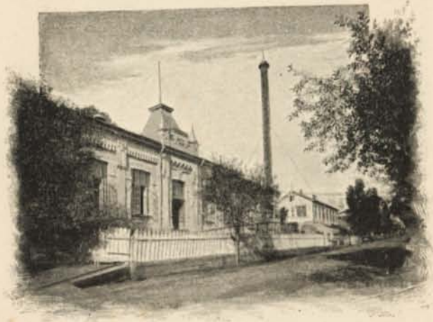
Stacja elektryczna tramwajów.
