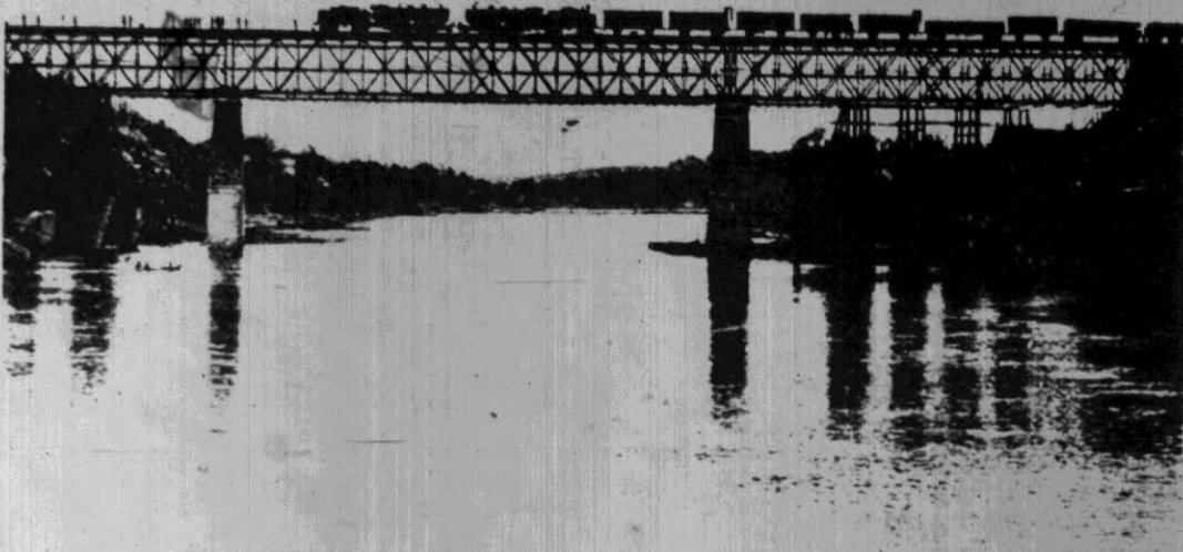
Uroczystość otwarcia mostu na Niemnie pod Grodnem. Pierwsza próba wytrzymałości mostu. Wagony naładowane ciężarem bez ludzi przejeżdżają most. (Fot. L. Gelgor w Grodnie).
