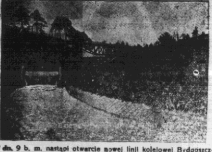
W dn. 9 b. m. nastąpi otwarcie nowej linii kolejowej Bydgoszcz-Odynia. Zdjęcie: Most kolejowy na nowej linii.
