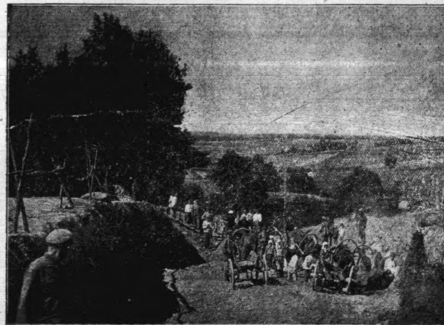
Budowa drogi wojewódzkiej Nowogródek—Świtez
