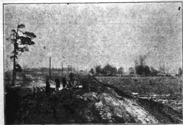
Specjalne maszyny drogowe przyspieszają budowę dróg w powiecie Nowogródzkim
