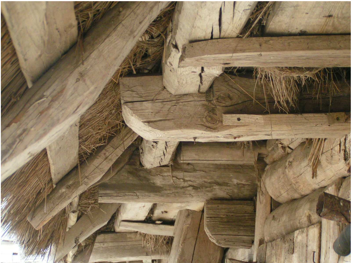
RYSUNEK 7.4.9. Typowa konstrukcja ścian, stropu i dachu. Wieś Ozierany w gm.Krynki. Fot. stud. W.A. P.B. Emilia Chrabin, 2005.
