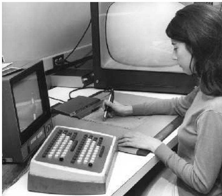
RYSUNEK A.9.1. Jeden z pierwszych digitizerów, RAND Grafacon (prace zapoczątkowano w r.1964 i ukończono w latach 70., wg [27])
