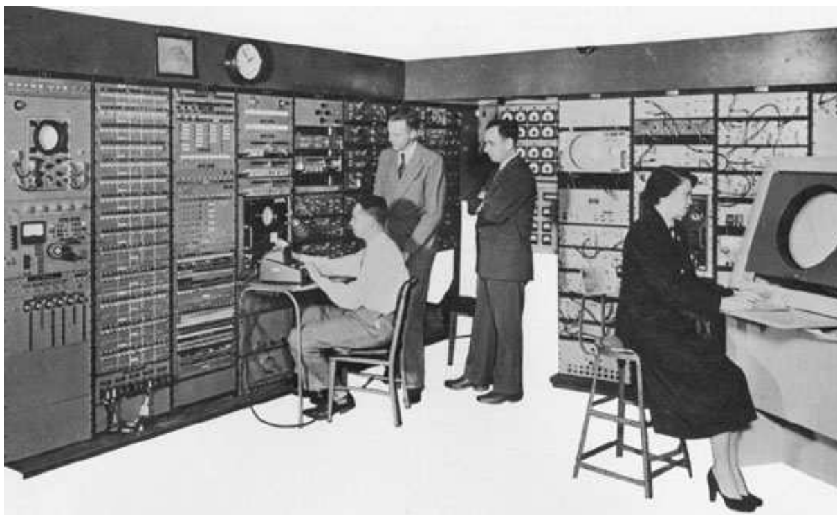
RYSUNEK A.1.1. Whirlwind – pierwszy komputer z graficznym wyświetlaczem wektoroskopowym. Źródło: [27]
