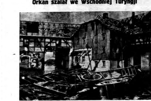
Na zdjęciu wór zniszczonej siłowni w domu.
