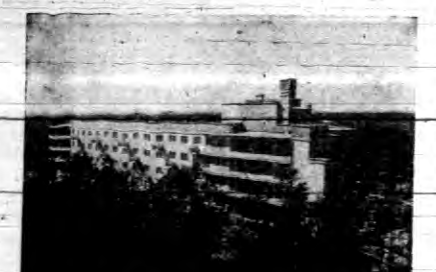
Główny gmach, zakończony z jednej strony wielkimi łazienkami. Na uwagę zasługują podłogi pokryte balustradami, na które wywiosa się lózka...
