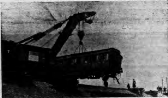
W wielkich warsztatach kolejowych P. S. M. w Toroncu we Francji uruchomiono specjalny dźwig do podnoszenia wagonów.
