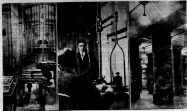
Ciekawe obrazy z Banku Francuskiego, który z swemi miliardami złotych jest największą skarbnicą złota na świecie. Na lewo: transport złota wewnątrz, w środku: wazony zamknięte, w prawo: rżnięcie złota na twierdzą podziemną, znajdująca się w głębokości 25 metrów pod ziemią. Nad tą pionową znajduje się sztuczne jezioro, którego woda w razie niebezpieczeństwa może zatopić skarbiec.
