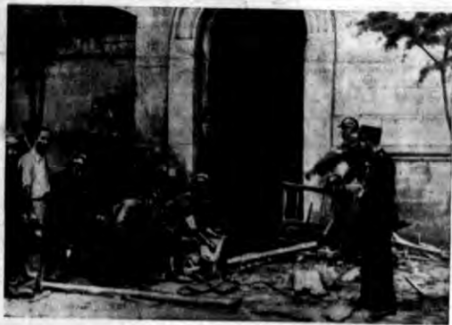
Prace przy domu w San Sebastian, który podczas ostrzału przez statek powstańczy został przebit granatem od dachu do piwnic.
