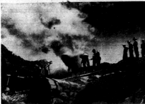
Włosey robotnicy podczas budowy drogi w Abisynji
