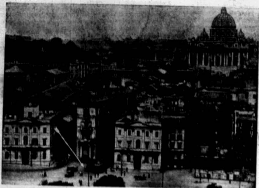
W dniu 28 bm. Benito Mussolini wyjmie jedną cegłę z Palazzo di Piazze, rozpoczynając w ten sposób burzenie całego bloku domów, na których miejscu powstanie ulica, prowadząca do kościoła św. Piotra.
