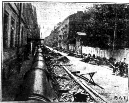
W chwili obecnej jest prawie na ukończeniu budowa wielkiego przewodu tłoczego o średnicy 1.20 m. który ma połączyć stację pomp na Czerniakowie ze stacją filtrów szybkobieżnych na Ochocie.
