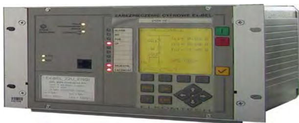
Rys.4.34. Widok zespołu automatyki zabezpieczeniowej Ex-BEL_Z2U [31]
