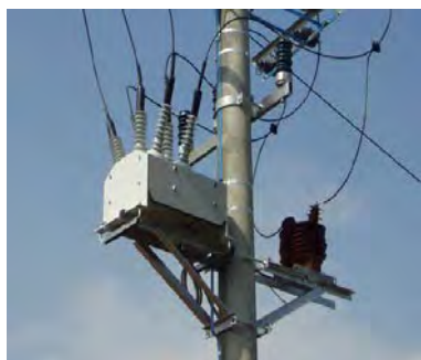
Rys.4.38. Widok z zainstalowanym na słupie reklozerelem typu KTR produkcji Tavrída Electric oraz schemat ideowy jego podłączenia do sieci [55]. Oznaczenia w tekście
