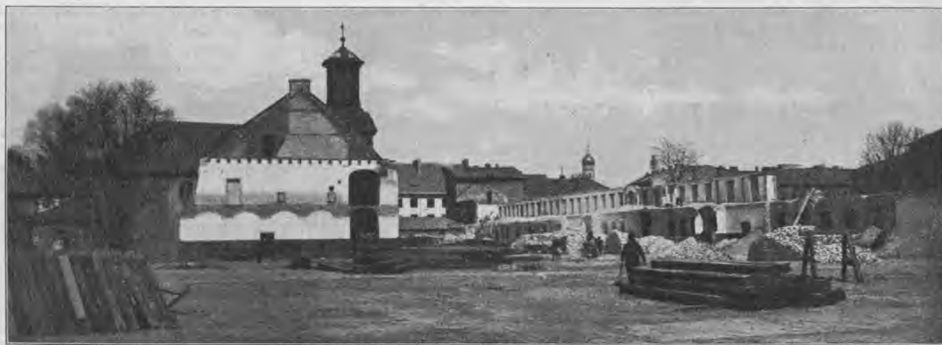
Rozbórka gmachu szpitalnego Dzieciątko Jezus. Na pierwszym planie kościołek, który zostanie przebudowany.
