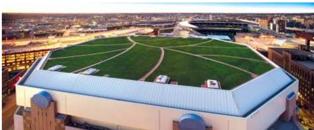
Rys. 78. Ekstensywny dach Target Center
