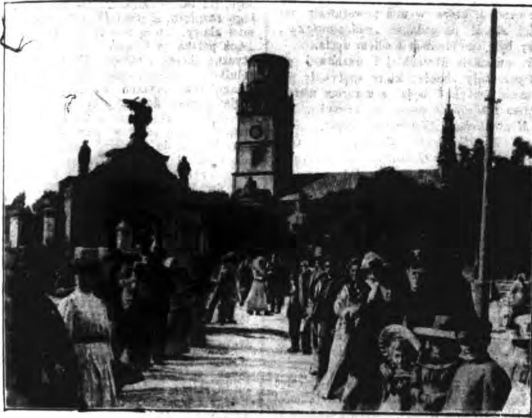
CZĘSTOCHOWA. Widok kościoła po pożarze.
