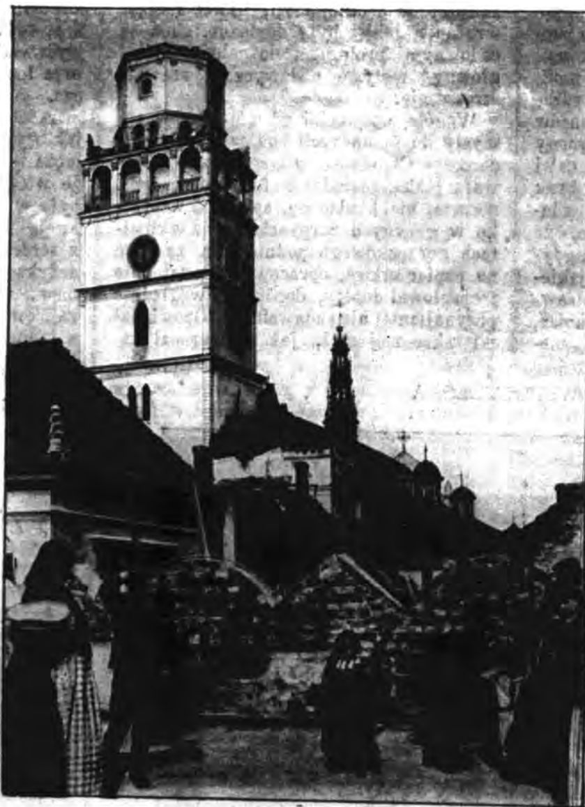
CZĘSTOCHOWA. Widok kościoła po pożarze.
