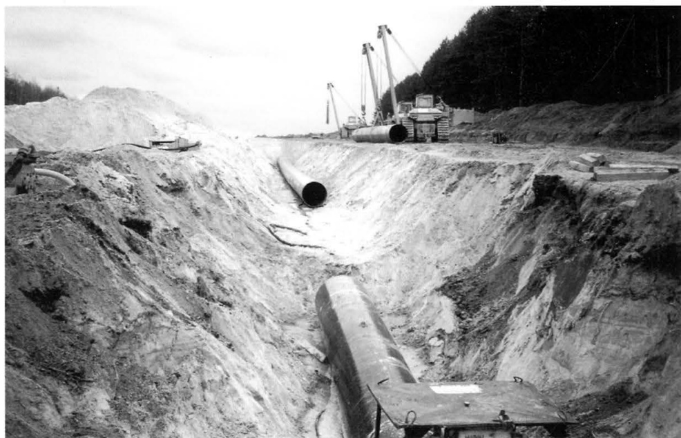
2. Widok stanowiska w Leonowiczach w trakcie budowy gazociągu. Fot. D. Krasnodębski View of the site in Leonowicze in the course of building a gas pipeline. Photo: D. Krasnodębski
