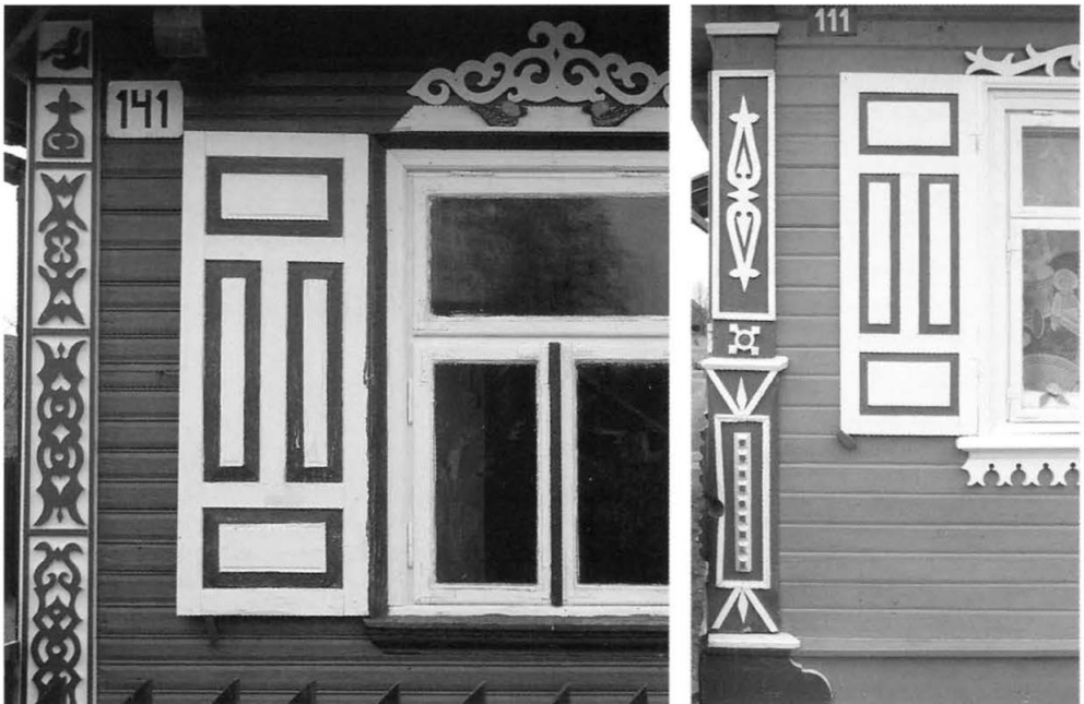
15. Elewacyjne układy kompozycyjne z ozdobnym deskowaniem naroży we wsiach Plutycze i Augustowo w gm. Bielsk Podlaski. Fot. studenci W.A. P.B. Elevation composition configurations with decorative boarding of the corners in the villages of Plutycze and Augustowo, commune of Bielsk Podlaski. Photo: students of W.A. P.B.
