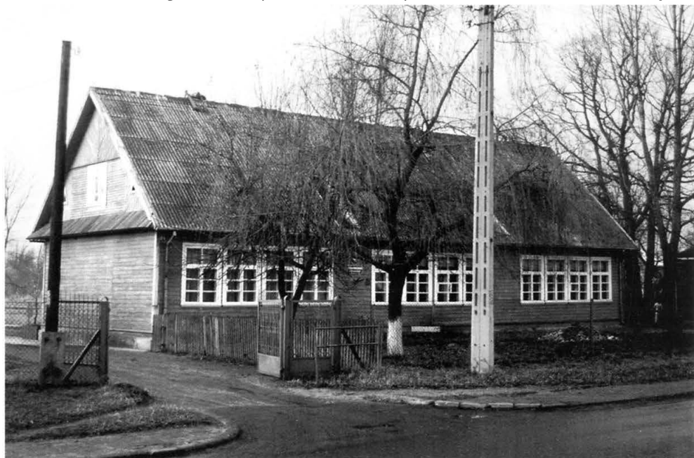
3. Nowoberezowo, gm. i pow. Hajnówka, szkoła przeznaczona do rozbiórki, stan z 1987 r. Fot. J. Sieńko, neg. WUOZ w Białymstoku, nr 4326A Nowoberezowo, commune and county of Hajnówka, school to be pulled down, state in 1987. Photo: J. Sieńko, negative: WUOZ in Białystok
