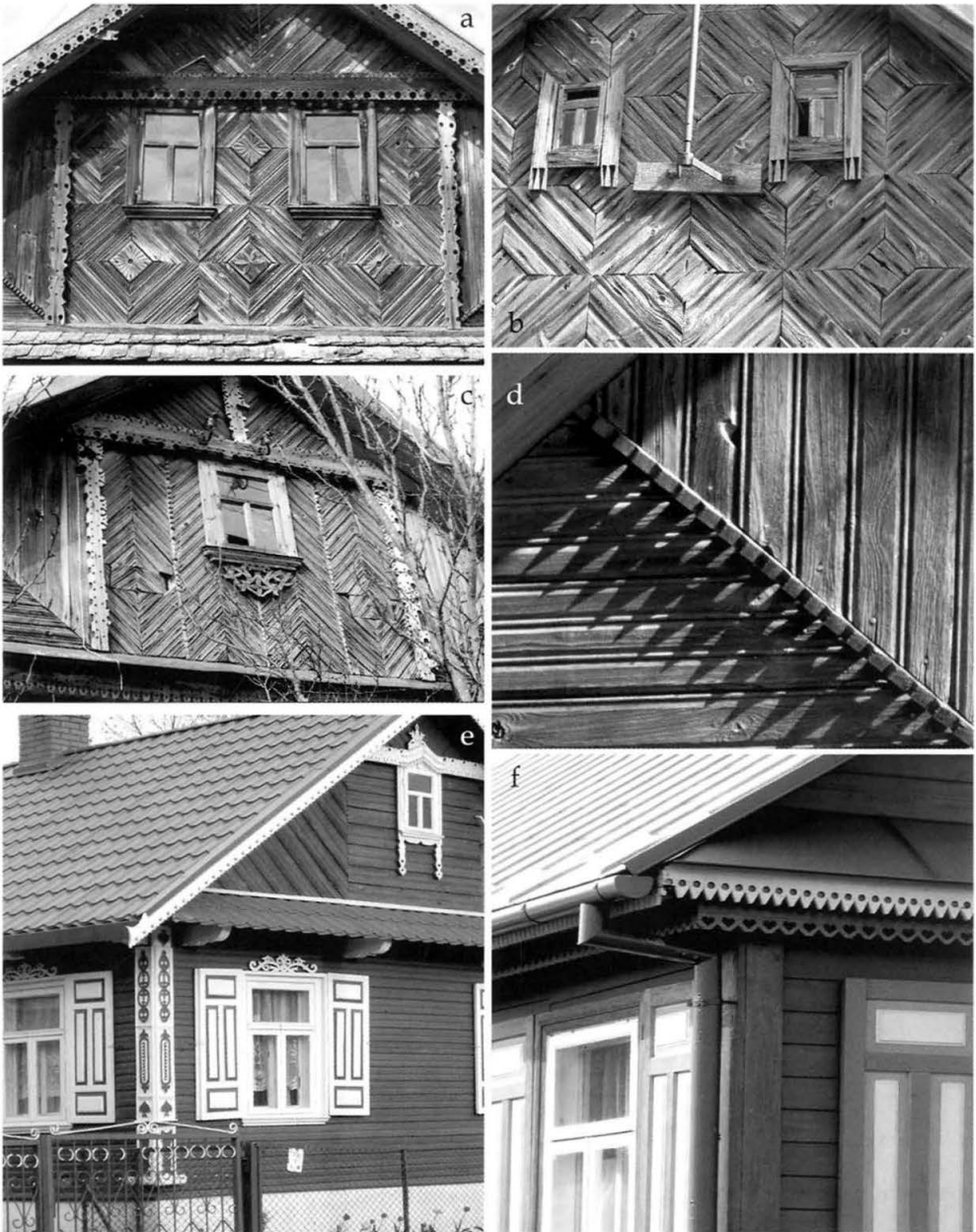
1. Motywy ornamentalne wycięte w deskach: a. Trywieża w gm. Narew; b. Mochnate w gm. Hajnówka; c. Cieluszki w gm. Narew; d. Doratynka w gm. Narew; e. Nowoberezowo w gm. Hajnówka; f. Plutycze w gm. Bielsk Podlaski. Fotografie wykonali studenci Wydziału Architektury P.B.; własność Zakładu Architektury i Planowania Wsi W.A. P.B.
