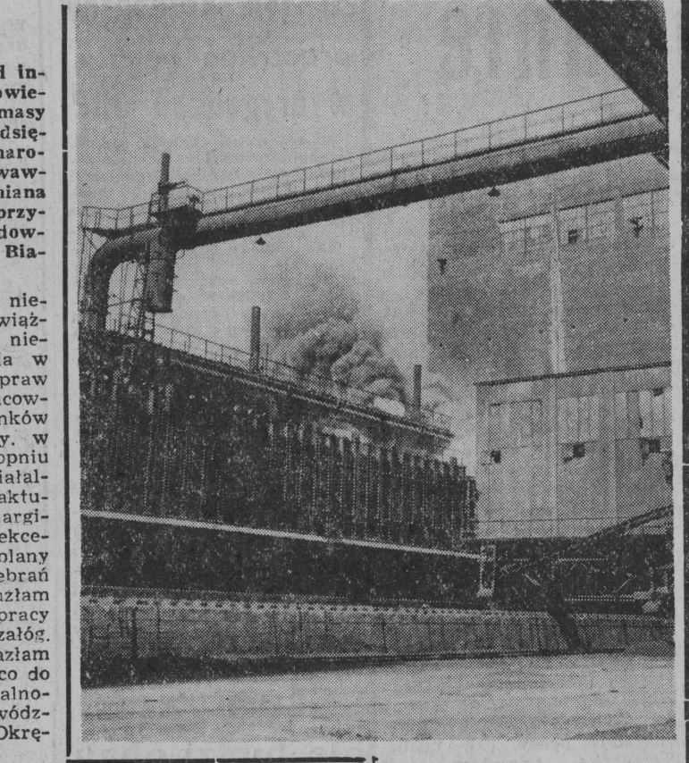
Prace budowlane w Białymstoku
