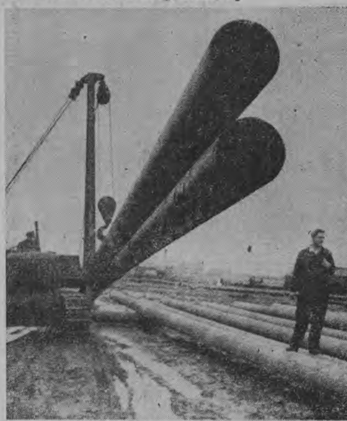
Zelazunek odcinków rur przed rozwożeniem na trasę gazociągu. Fot. W. Kostin
