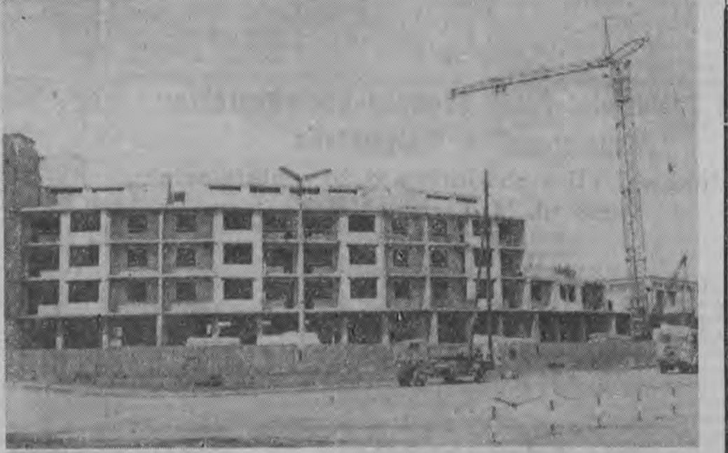
Nowy blok mieszkalny obok dworca kolejowego buduje Białostocka Spółdzielnia Mieszkaniowa.
