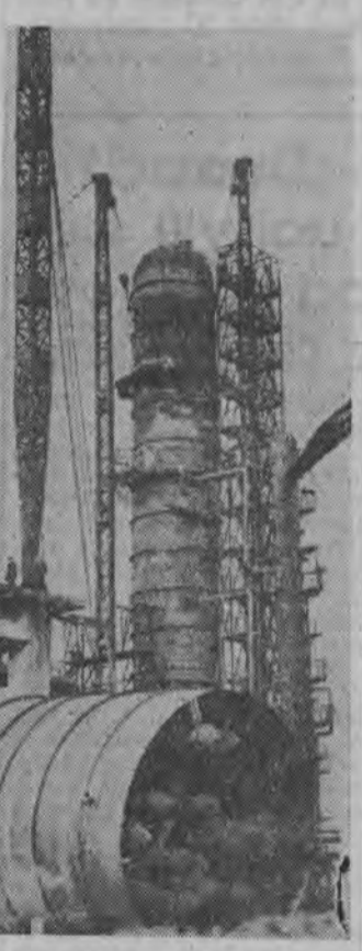
Montaż nowych urządzeń w największej rafinerii ropy naftowej w Azerbejdżańskiej SRR. CAF
