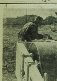
Na budowie nowoczesnej chłodni w Białymstoku trwają intensywne prace. Na zdjęciu: przygotowanie wala do ubijania terenu.
