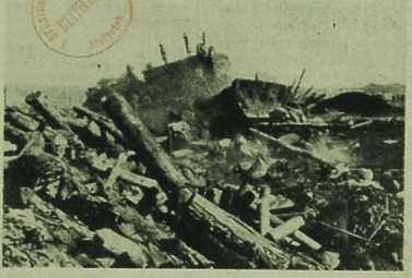
Budownicy niszczą umocnienia i bunkry w bazie Khe Sanh, która 5 km. opuszczyła osłonie oddziały amerykańskiej piechoty morskiej. CAF — Unifax
