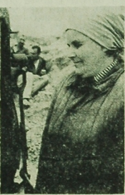
Nina Mielnik pracuje przy budowie Zakładów Granicznych w Białymstoku.
