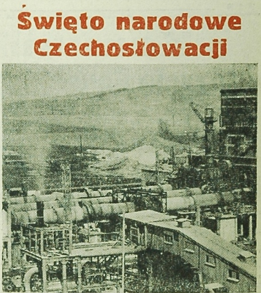
W dniu tegorocznego święta narodowego przemysł czechosłowacki otrzymał nowy wielki obiekty produkcyjne w wschodniej Słowacji. W maju uruchomiony zostanie pierwszy piec rotacyjny w Słowackich Zakładach Magnezjowych w miejscowości Jelsava. Dzięki tej inwestycji produkcja magnezytu w ciągu najbliższych 3 lat zaspokoi potrzeby przemysłu wewnętrznego i umożliwi 3-krotne zwiększenie dotychczasowego eksportu Czechosłowacji magnezytu i jego pochodnych. NA ZDJĘCIU: widok ogólny Zakładów Magnezjowych w Jelsawie. GAF — CTK
