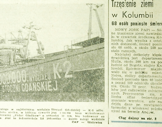
MILIONOWA TONA W dniu 11 lutego w najstarszym wydawnictwie Stoczni Gdńskiej — K-1 odbyła się wodowanie kolejnego kadłuba statku, w którym zawarta jest 1 000 000 tona budowanych przez ten wydział. Jest to drobniaki, jedyną w notowaniu 12 tys. ton budowany na zamówienie armatora radzieckiego. Jest to jednocześnie 21 jednostka — dzieło siłoci wydziału K-2. CAP — Białostok
