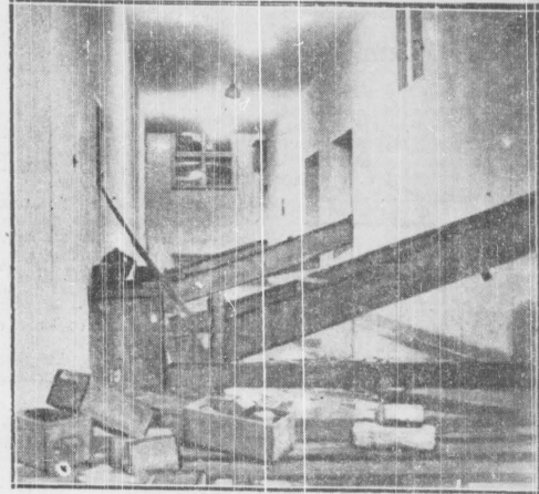
Obraz zniszczenia w głównym korytarzu wiodącym do auli Nr. 2.
