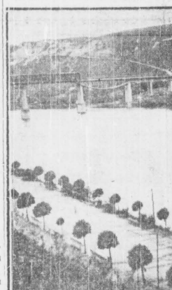
Widok z plaży zaleszczyckiej na most kolejowy nad Dniestrem.
