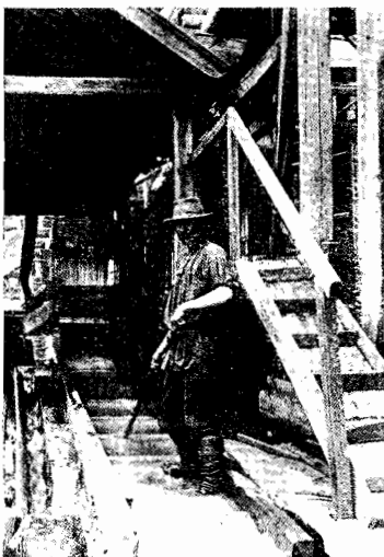
Rys. 86. Amerykanka do przemywania piasków złotonośnych na kopalni Kazakowskiej, w Nerczyńskim okręgu górniczym (ze spraw. stud. Kenka).
