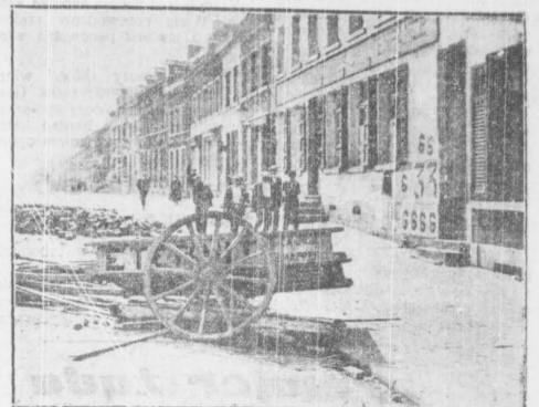
Pół miliona robotników belgijskich porzuciło prace. Policia zwalcała usilnie terrorystów strajkowych. Oto reszki barykad na ulicach Jemmapes.
