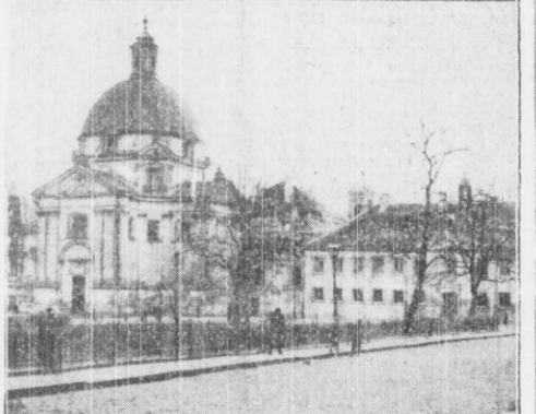
Kościół i klasztor S.S. Sakramentek, w którym od strony Wisły część mur- ów uległa zarysowaniu.
