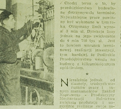
Urządzenie do badania i regulacji pomp wtryskowych obsługujące E. Zajkowskim
