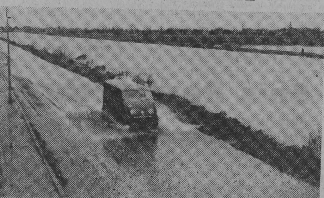
NA ZDJĘCIU: wezbrane wody kanału Haarlem wystąpiły z brzegów. CAF
