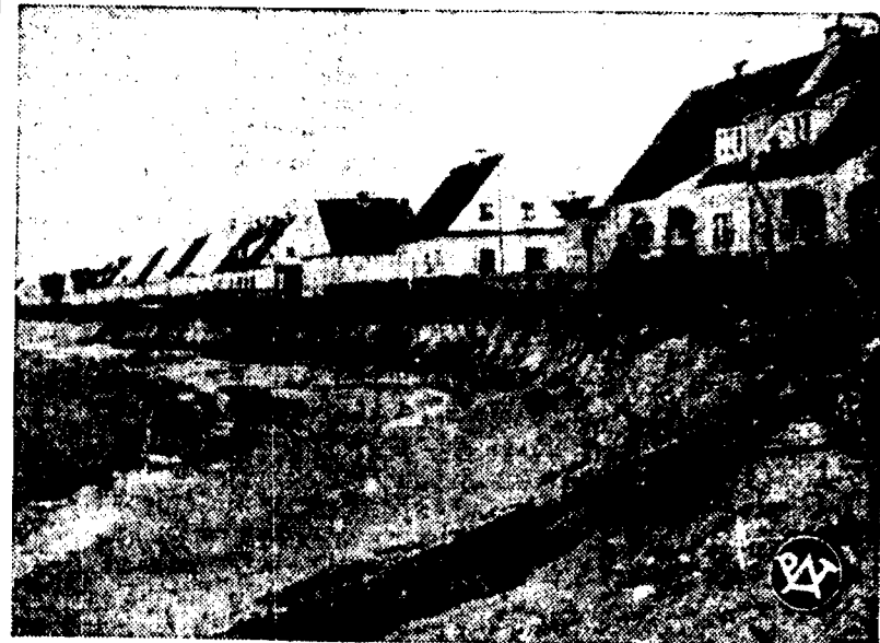
Zabezpieczone morkami brzegi Malej Plaży na Helu znowu zostały podmyte. Fale zabraly umacniające wyrmy morki z piaskiem i znaczny znowu kawał brzegu.
