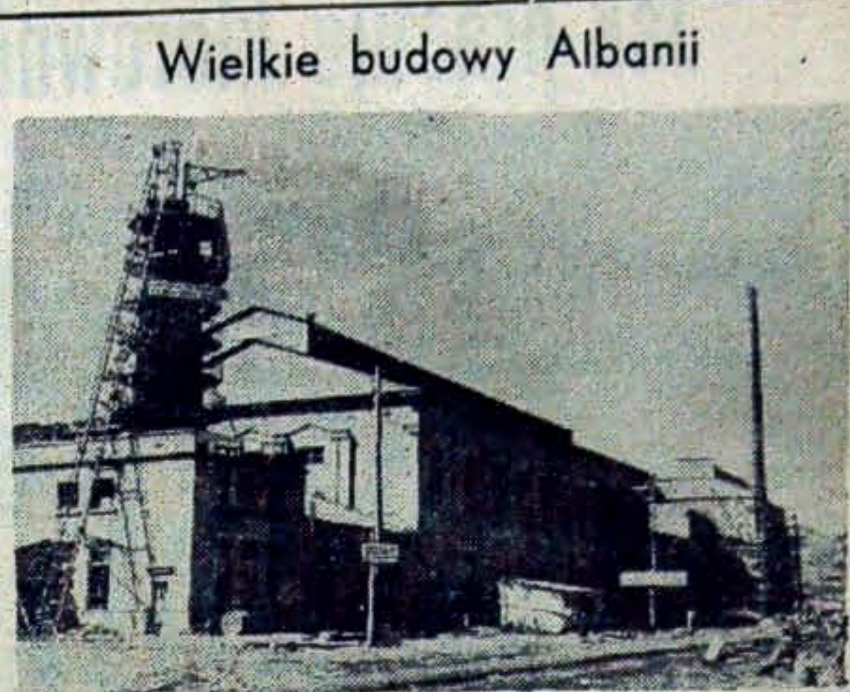
Wielkie budowy Albanii. Dzięki pomocy Związku Radzieckiego Albania zmienia swe oblicze gospodarcze. Z kraju zacofanego gospodarczo staje się ona krajem uprzemysłowionym. Ostatnio ukończone zostały trzy wielkie budowy: elektrownia wodna „Lenin”, kombinat włókienniczy „Stalin” oraz rafineria cukru w Mallig. Wszystkie maszyny i urządzenia sprowadzono z ZSRR. Na zdjęciu: Rafineria cukru w Mallig. fot. CAP.
