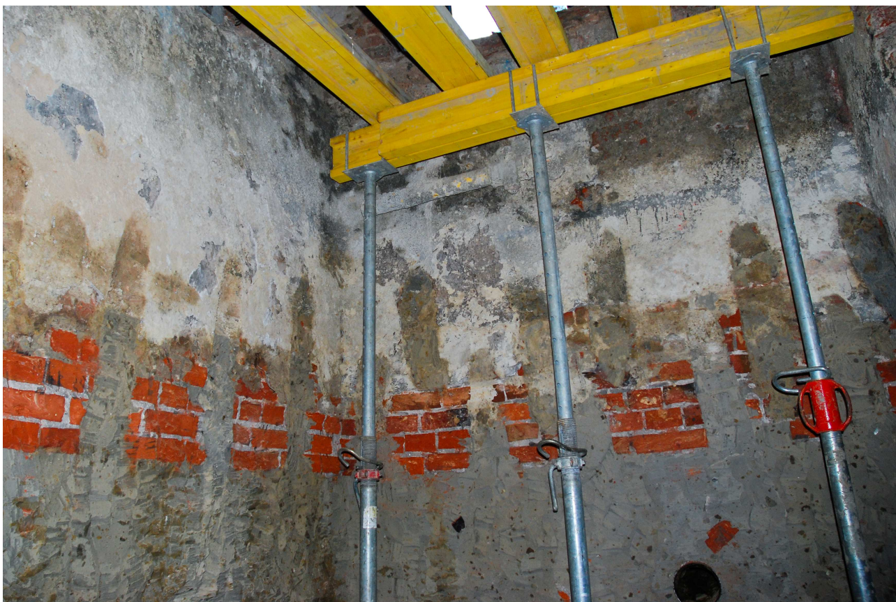
Rys. 3. Podchwycony iniekcyjnie fundament kamienicy w Alejach Jerozolimskich w Warszawie z usuniętymi odsadzkami. Widoczne miejsca przewierćów przez ławy ceglane (fot. własna)
