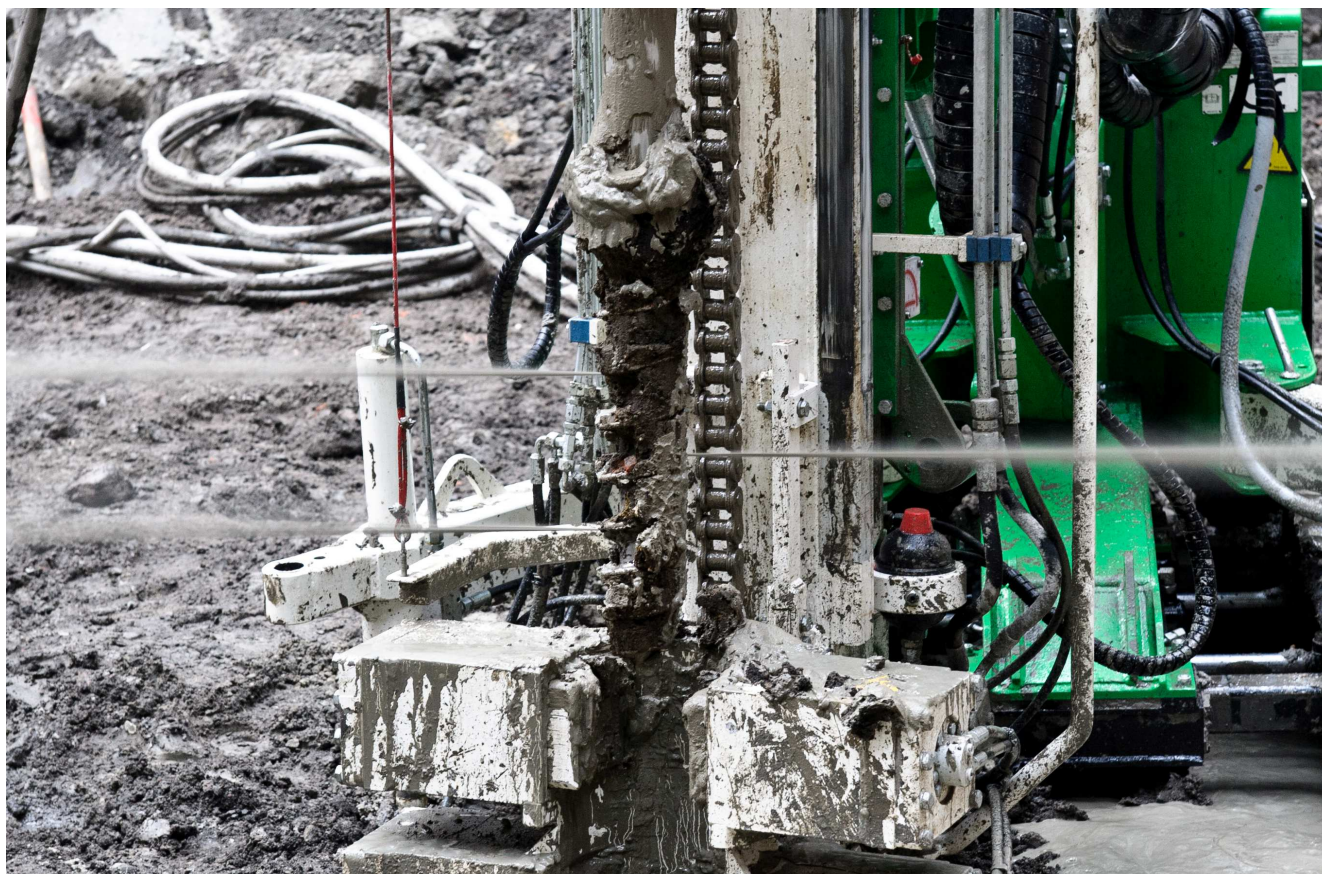
Rys. 1. Wysokoenergetyczny strumień iniektu formujący kolumny iniekcyjne (fot. własna)
