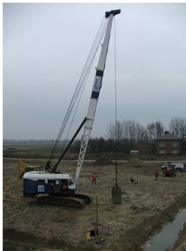
Rys. 2. Formowanie wbijanej kolumny kamiennej
