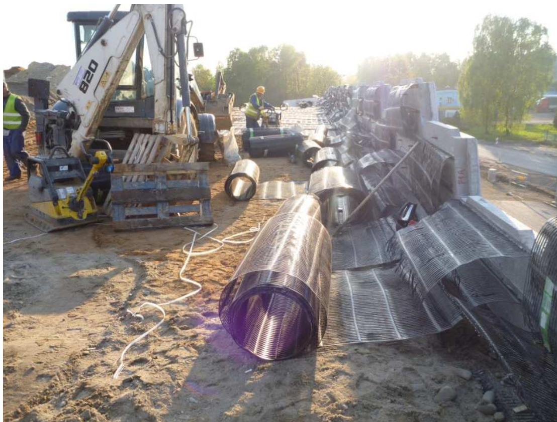
Rys. 2. Widok zbrojenia głównego łączonego ze starterami zabetonowanymi w panelach
