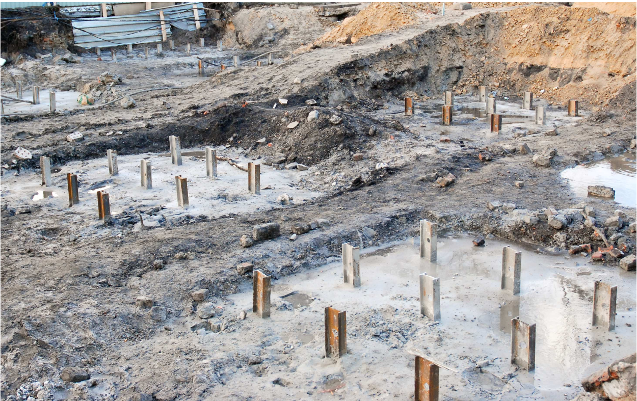
Rys. 7. Wykorzystanie zrzutów technologicznych jako wstępnej podbudowy pod warstwy konstrukcyjne przy rozbudowie siedziby oddziału ZUS w Sosnowcu (fot. własna)
