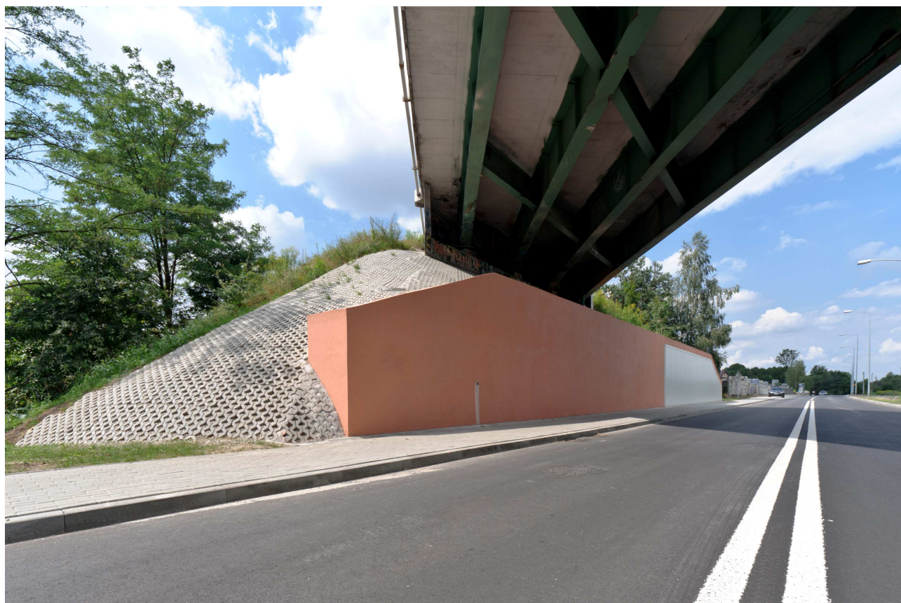
Rys. 6. Konstrukcja oporowa podtrzymująca skarpe przyczółka wiaduktu w Żorach (fot. własna)
