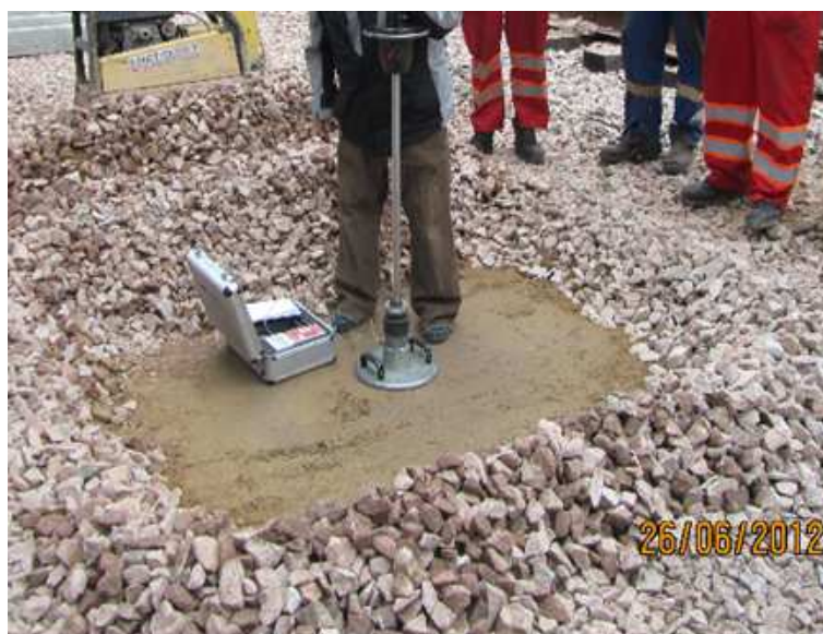
Rys. 2. Płyt ZFG-02 w trakcie badań
